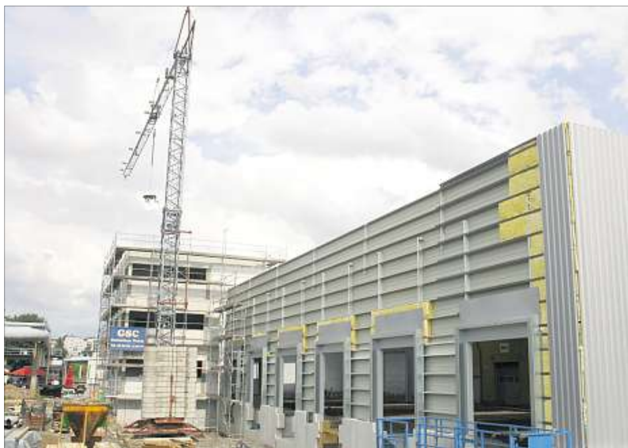
Der Richtkranz schwebt über dem neuen Logistikzentrum, um das Kaeser Kompressoren sein Geraer Werk erweitert. (Foto: OTZ/Uwe Müller)
